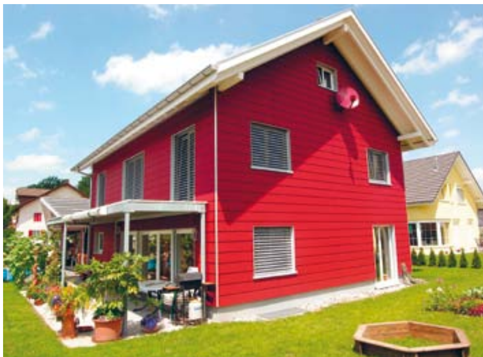
Das Klimahaus von Kaufmann Oberholzer unterstreicht die Holzbaukompetenz des jubilierenden Unternehmens.
