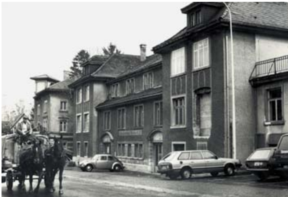
Diese historische Aufnahme aus dem Jahr 1975 zeigt das alte Produktionsgebäude an der Bodanstrasse in Kreuzlingen.
